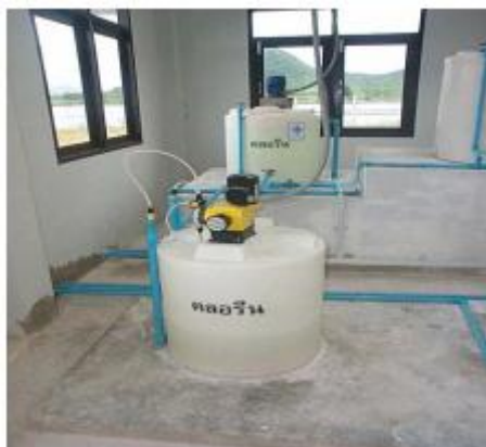
รูปที่ 2.9 เครื่องจ่ายสารละลายคลอรีน
