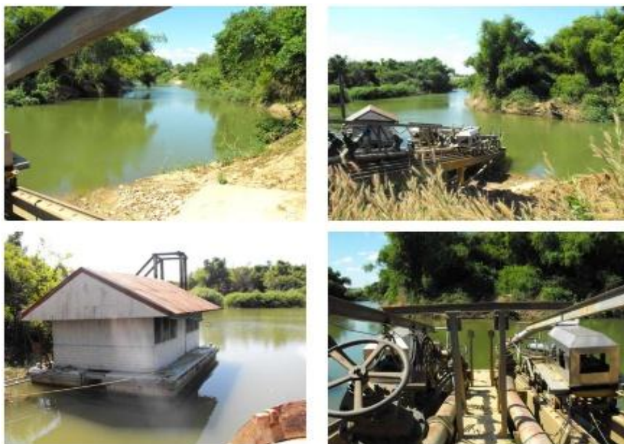
รูปที่ 4.1 คลองพระสะทึง แหล่งน้ำดิบและระบบสูบน้ำดิบ ของ กปภ.สาขาสระแก้ว
