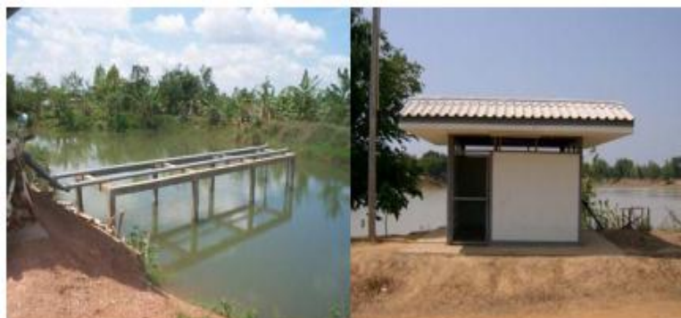
รูปที่ 2.12 ท่อส่งน้ำดิบและโรงสูบน้ำดิบระบบประปาแบบผิวดิน
