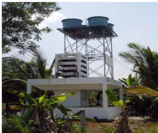
รูปที่ 2.15 ระบบประปาหมู่บ้านตามแบบกรมโยธาธิการ
