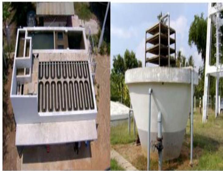
รูปที่ 2.13 ถังกรองน้ำ
